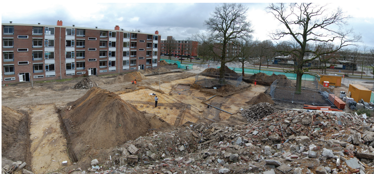
Afb. 4.9 De resten van het hoofdgebouw in het opgravingsvlak met de monumentale eiken in de werkput.
