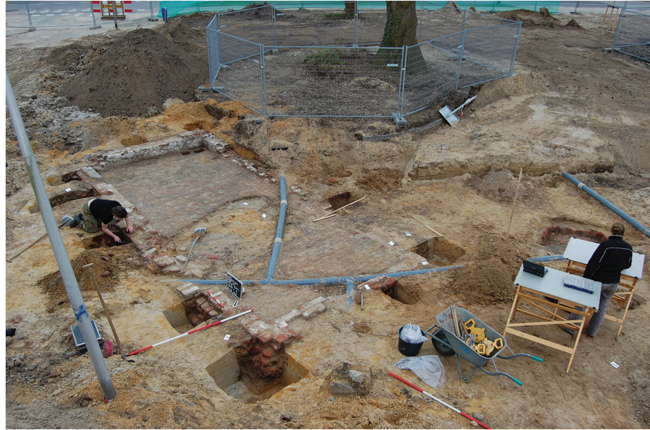
Afb. 4.12 Het couperen en documenteren van de funderingen van de kelder. Door de kelder liepen verschillende moderne pvc-buizen.
